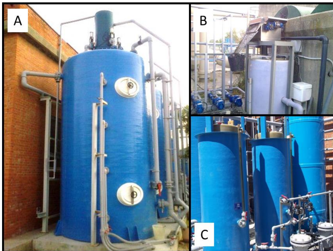
Figura 1: (A) Reactor anaerobio UASB, (B) tanque receptor de agua tamizada, y bombas de alimentación y (C) gasómetros de cúpula flotante.
