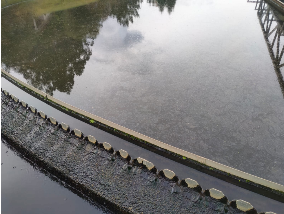
Figura 1.2. Efectos de la presencia de nutrientes en el agua de salida de una depuradora.
