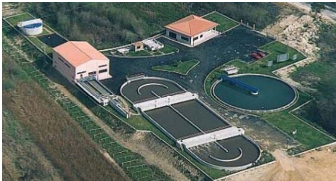
Figura 6.1. Vista aérea de una EDAR con tratamiento biológico por lodos activos.
