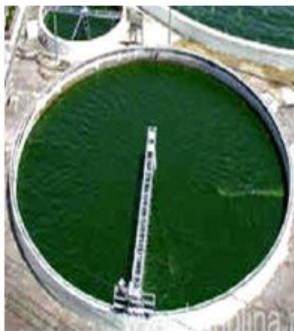
Figura 1 - 25. Estanque circular para el cultivo de microalgas. Fuente: Y. Shen et al. (2009) [244].
