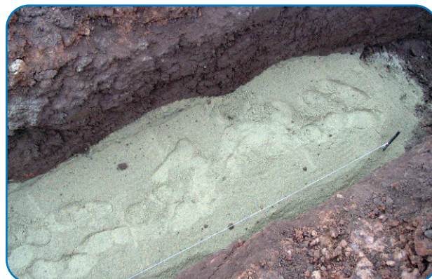
Foto 6 y 7. Detalle de la cama y colocación del geotextil.
