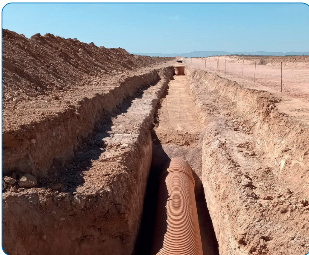
Foto 8. Relleno alrededor del tubo.
