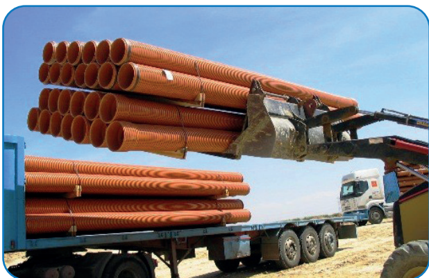
Foto 1 y 2. Descarga de paquetes con pinzas.
