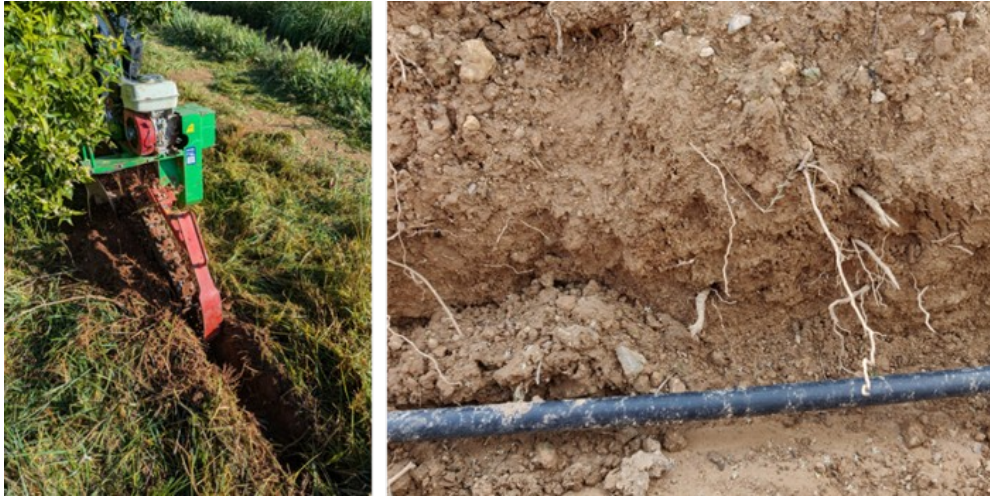
Figura 2.- Detalle de la zanjadora utilizada para enterrar la tubería del sistema de riego subterráneo (izquierda). Detalle de la ubicación en el suelo de la tubería enterrada (derecha).
