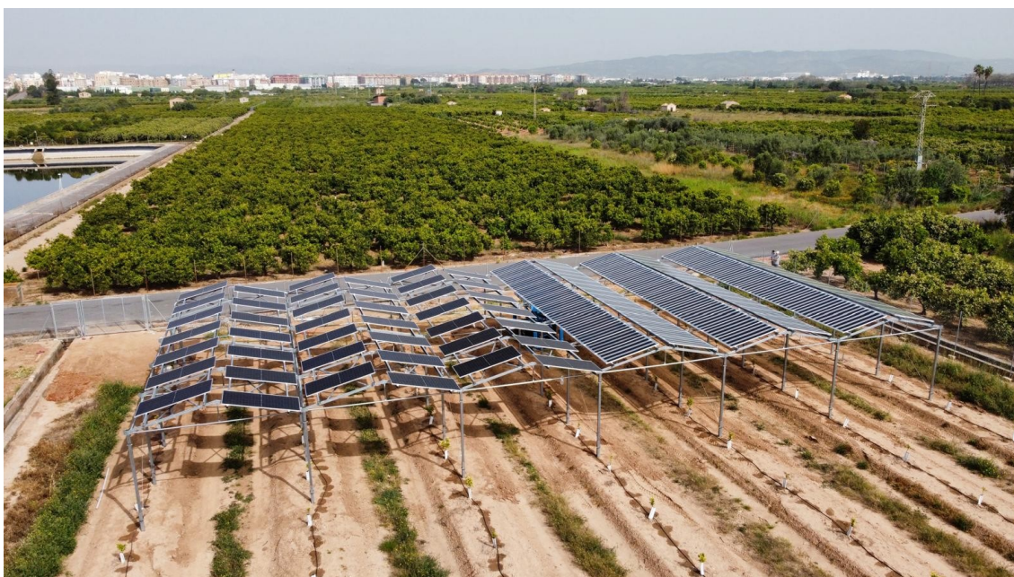
Figura 10.- Sistemas fotovoltaicos instalados en la parcela de cultivo
